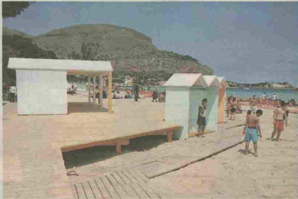
La piattaforma montata dalla società Italo-Belga sulla spiaggia di Valdesi
